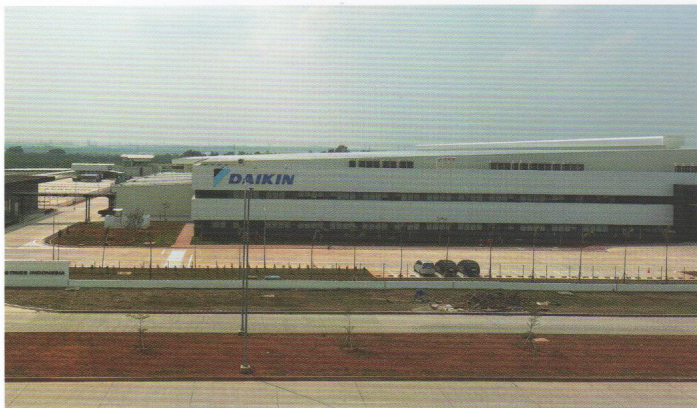
Pabrik Daikin Indonesia - Jawa Barat
